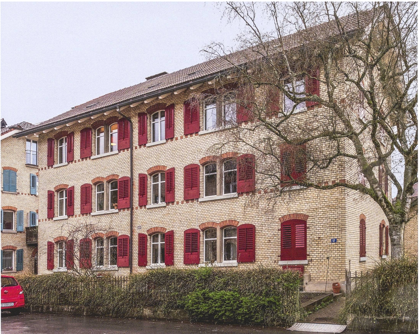
Das Haus an der Eichliackerstrasse 11 in Winterthur gehört seit 2011 der Gesewo. Eine energetische Erneuerung erfolgte 2017, wegen Feuchtigkeit waren letztes Jahr weitere Massnahmen nötig.
