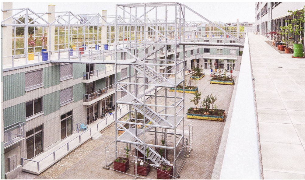
Verbindender Laubengang im vierten Obergeschoss (rechts) und offene Treppe im Hof.
