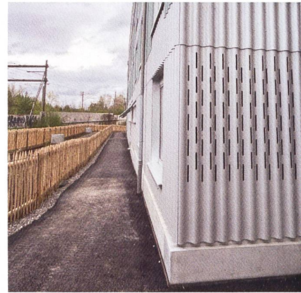
Der Westhof öffnet sich ins Quartier, hier zum Weg neben dem Bahndamm (oben). Ein schmaler Gartenstreifen vor dem Haus wird künftig von den Bewohner:innen bewirtschaftet.
