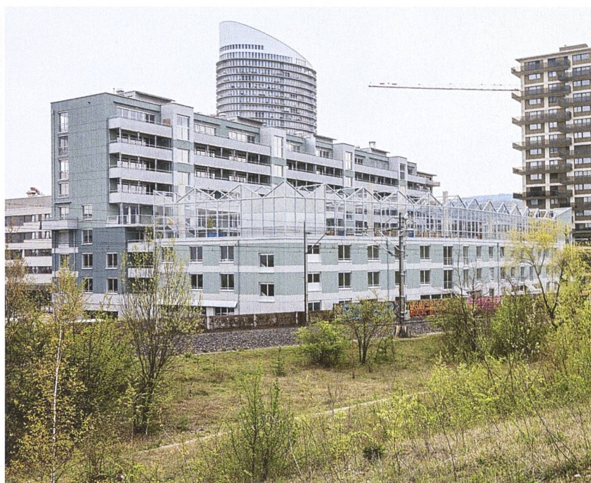
Gesamtes Gebäude von der Allmend Stettbach aus aufgenommen. Der tiefere Flügel zum Bahndamm dient als Lärmschutz. Im Hintergrund einige der Bauten, die im Hochbord aus dem Boden schießen; weitere Wohntürme sind geplant.
