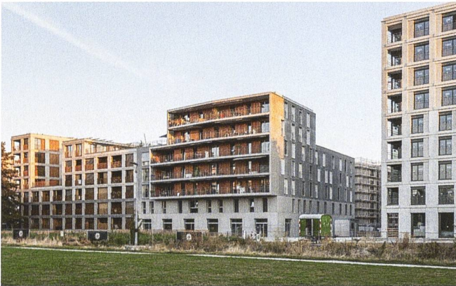
Das L-förmige Genossenschaftsgebäude (auf dem Luftbild über der Mitte links) bildet den Auftakt einer der beiden Blockrandüberbauungen von Baufeld E und setzt dies mit einer erhöhten Ecke in Szene. Es liegt an der Durchgangssachse und neben dem Park.
