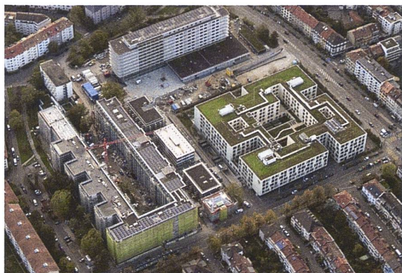
Westfeld-Areal: Das Leuchtturmprojekt von IWB für integrierte Energielösungen
