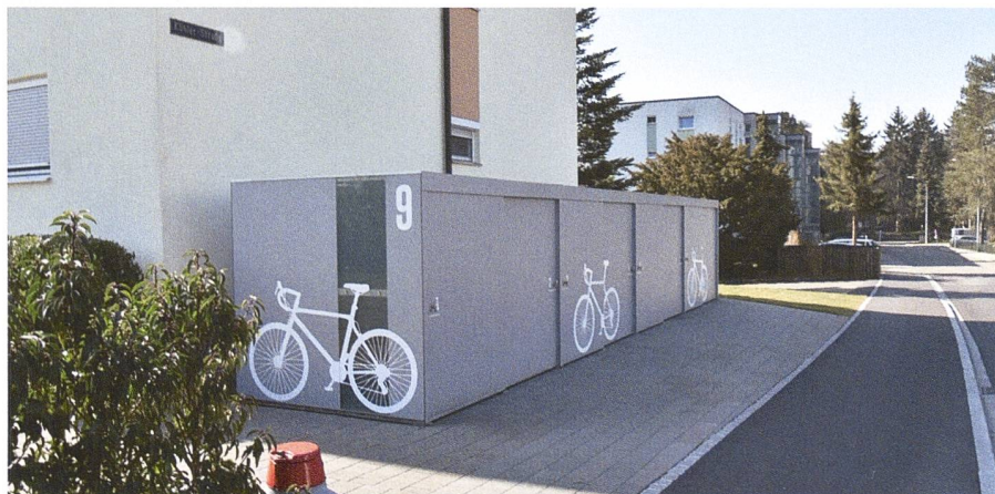
Velogarage Wohnbaugenossenschaft Kohlplatz, Rheinfelden
