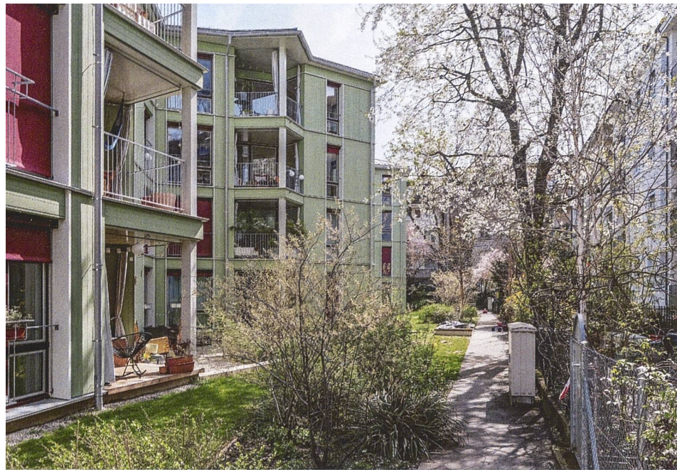
Beitrag zur qualitätsvollen Innenentwicklung: Im Hof einer Blockrandbebauung am Basler Riehenring hat Wohnstadt 2020 einen viergeschossigen Hofbau mit 36 Wohnungen erstellt.
