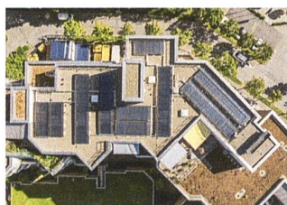
Der Stromertrag der Solaranlagen wird mindestens zehn Prozent des Eigenbedarfs decken.
