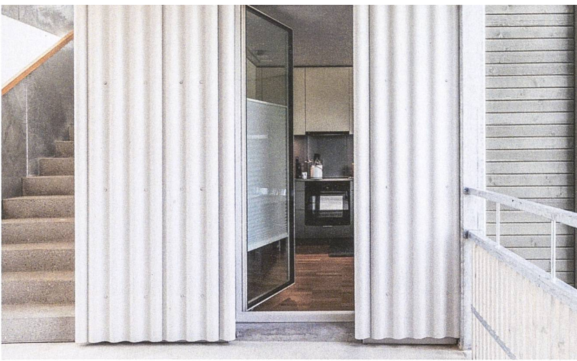
Fenstertüren an den Treppenhäusern sollen den Austausch fördern.
