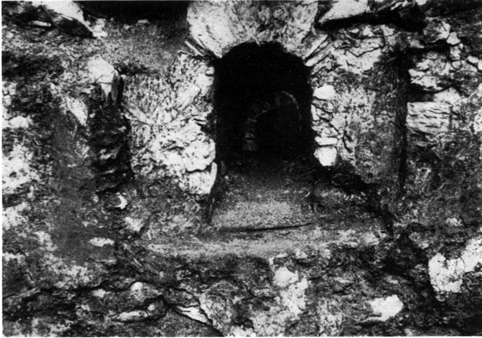
Abb. 8. Das Fenster zum Oratorium. Außenansicht.
