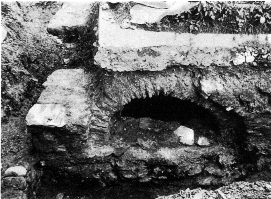
Abb. 9. Die Fensterfassung des Seitenstollens. Außenansicht.
