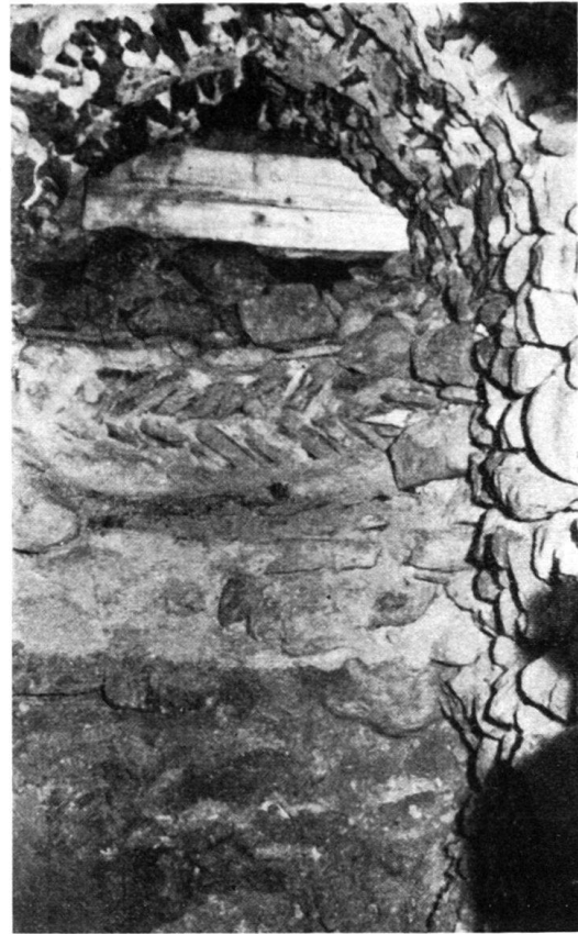
Abb. 7. Fensteröffnung des Seitenstollens von innen, vor der Ausgrabung.
