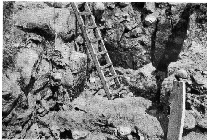
Abb. 3. Vermauerte Türe der Südwand BURG UND STÄDTCHEN MÜLENEN (Berner Oberland)
