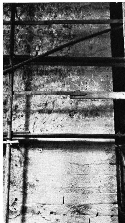
e. Nordwand, Ecke H, Verstärkung mit Sandsteinquadern; unterer Teil
