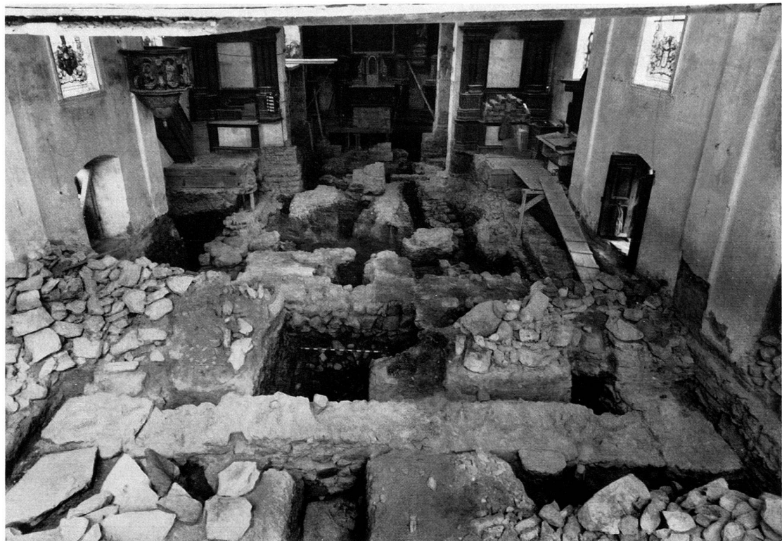
Tuggen, Pfarrkirche. Archäologische Untersuchungen von 1958; Gesamtübersichten der freigelegten alten Mauerzüge. a Blick auf die Reste der drei ersten Chöre ( a frühmittelalterliche Apsis, a' frühmittelalterlicher Altar, a'' Rest des Fundaments der Südmauer der frühmittelalterlichen Kirche, b romanische Apsis, c Nordmauerrest des gotischen Polygonalchors, d gotischer Kreuzaltar, d' gotischer Tonplattenboden, mit Sandsteinplatten geflickt). – b Blick von der alten Empore nach Osten. Vordergrund mit den beiden Westmauern der romanisch-gotischen Kirche.
