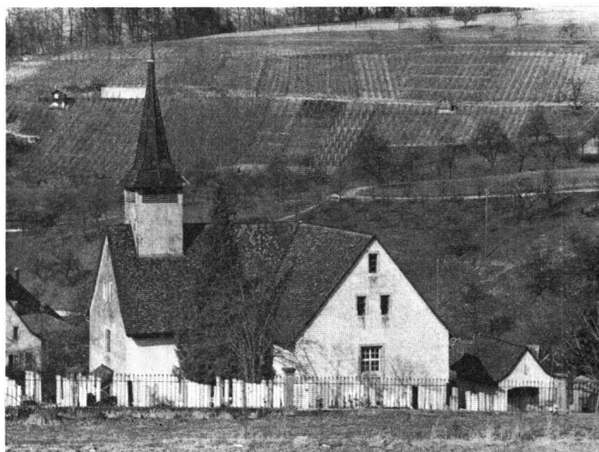
Abb. 9 Wintersingen, Kirche. Südansicht
