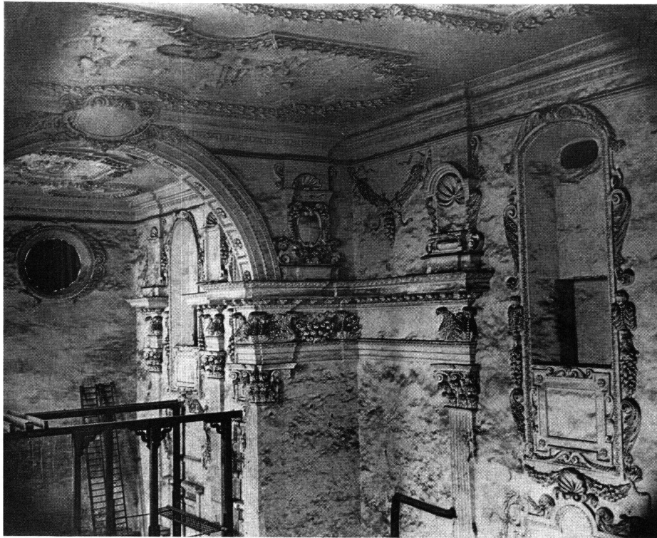
Abb. 19 Pruntrut, Jesuitenkirche. Ansicht vom Schiff gegen den Chor. Aufgenommen vor dem Einbau der Turnhalle, 1898. – Mit dem Einbau der Balkenlage für die einzuziehende Decke ist bereits begonnen worden
