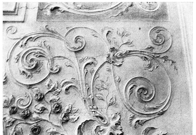
Abb. 18 Stans, Regierungsgebäude. Detail der Stuckdecke im 1. Stock (vgl. den Mittelspiegel an der Decke des Schiffs in der Jesuitenkirche in Pruntrut, Abb. 28)
