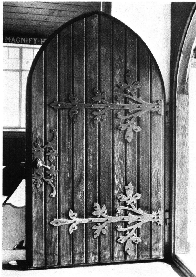
Fig. 14 Street: L'église anglicane de Mürren, bâtie en 1878. Portail
