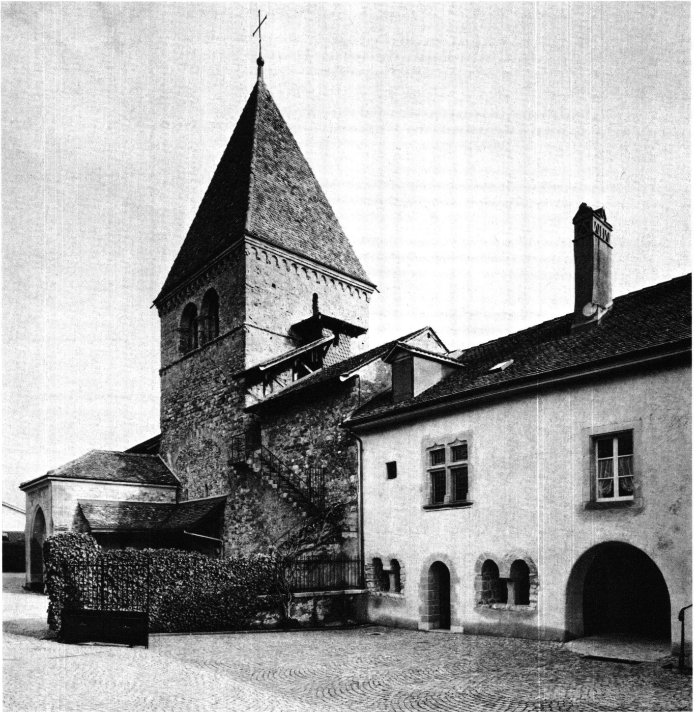
Fig. 21 Les bâtiments conventuels après la restauration
