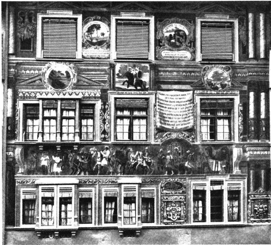
Abb. 20 Schaffhausen, Haus zum Großen Käfig. Fassade, 1675
