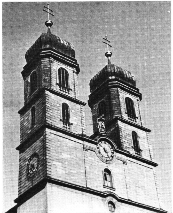
Abb.35 Obere Partie der Turmfront. Photo von etwa 1947
