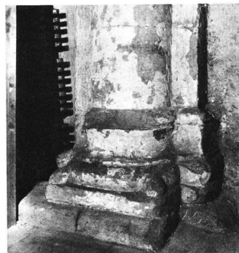
Abb. 15 Romanischer Pfeiler mit Halbsäule, in der Ostwand der Empore
