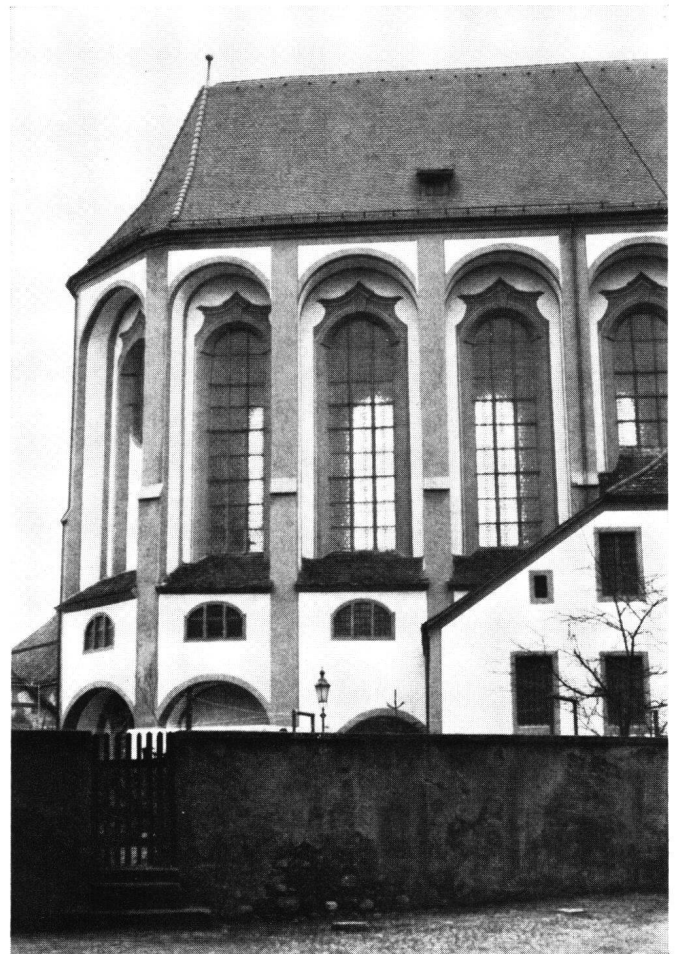
Abb. 17 Der Chor von Norden, Aufnahme 1975
