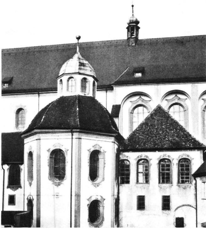
Abb.32 Oktogonkapelle und Oratorium an der Südflanke des Münsters. Außenansicht
