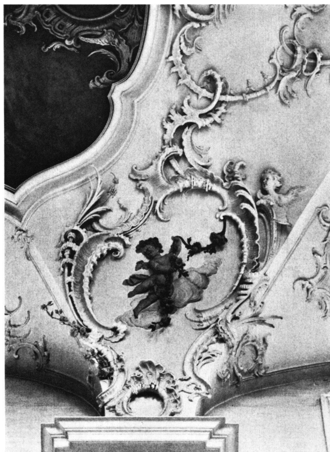
Abb.60 Langhaus Südseite: Kartusche am ersten Gewölbeanfänger von Osten, 1752/53
