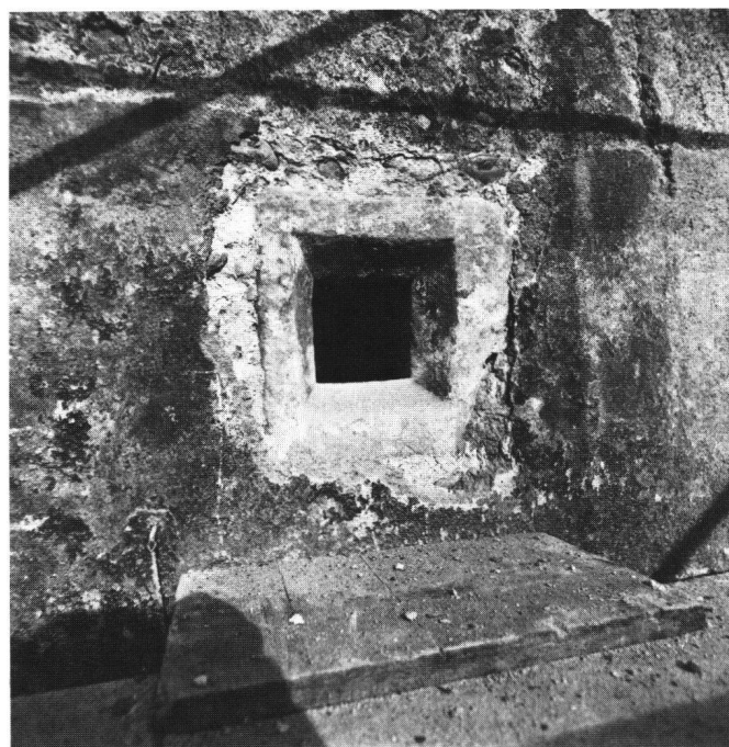
Abb. 7 Aussen- und Innenansicht des Lochfensters oder Spions von etwa 1330 in der westlichen Brandmauerscheibe des hofseitigen Kernbaus.
