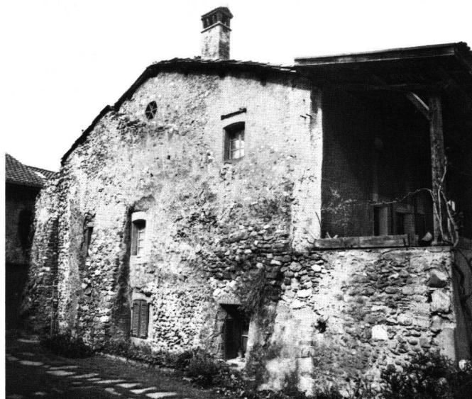
Fig. 17 Rue du Nord no 13, le mur oriental avec les traces de l'ancien pignon.
