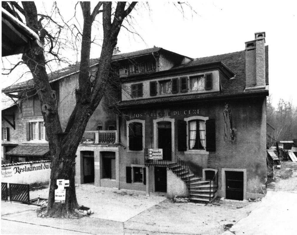
Fig. 14 L'Hostellerie du Cerf côté rue du Nord.
