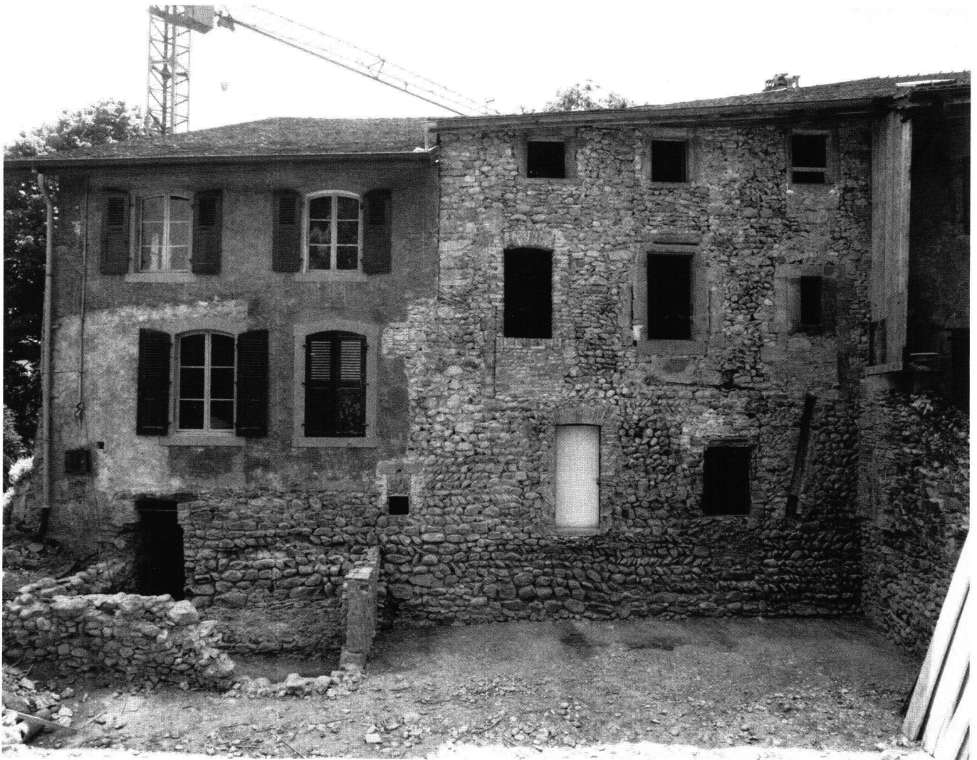
Fig. 4 La façade nord de l'Hostellerie du Cerf, ancienne enceinte.
