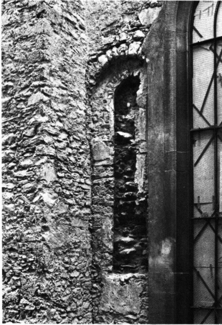
Abb.9 Das mit dem karolingischen Bau entstandene Fenster nach partieller Entfernung der Vermauerung. Links ein spätgotischer Strebpfeiler; rechts ein Fenster von 1918.
