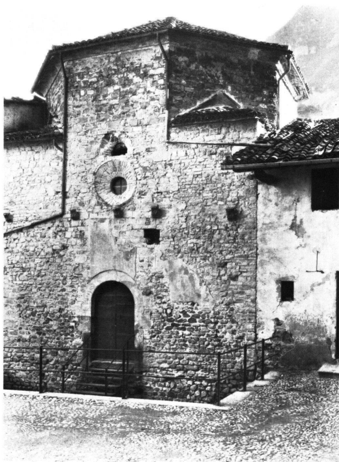
Fig. 2 Visione generale del lato occidentale prima dei restauri.
