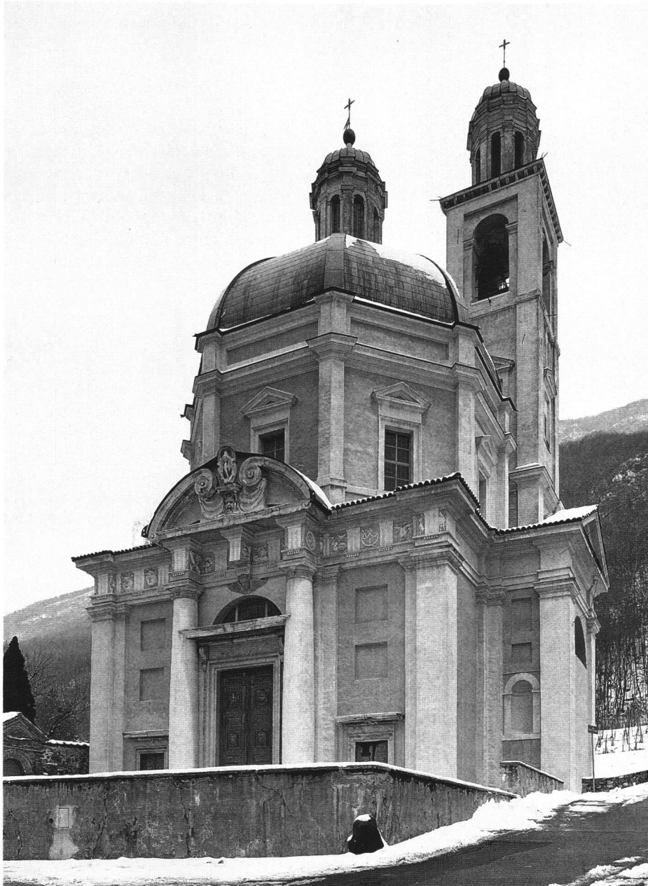
Abb.1 Santa Croce in Riva San Vitale von Osten, nach der Restaurierung 1973-1975 (Foto 1991).
