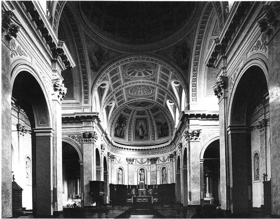
Fig. 17 Monthey, église catholique (1850-1851), par Emile Vuilloud. Vue de la nef en direction du chœur, état en 1973.
