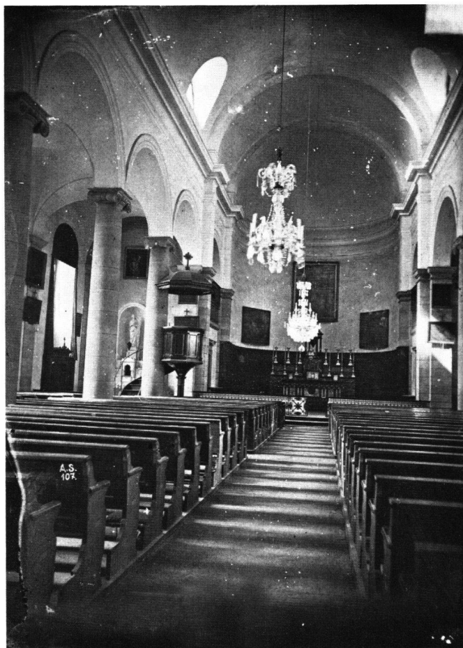
Fig. 16 Lausanne, église catholique du Valentin (1832-1835), par Henri Perregaux, architecte. Vue de la nef en direction du chœur, photo d'archives André Schmid, fin XIX e siècle.
