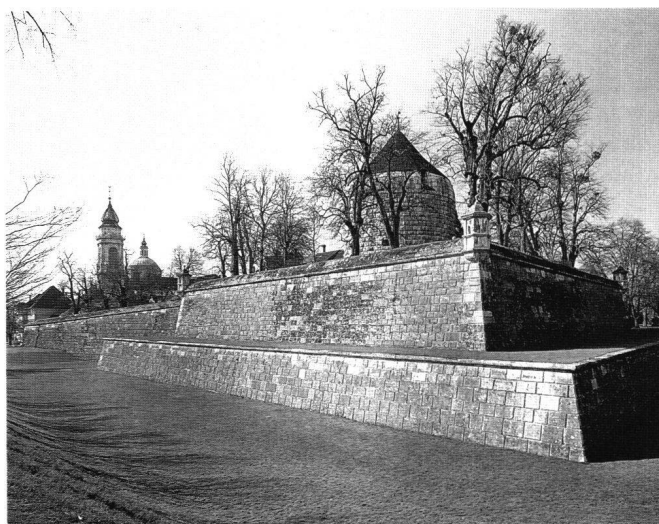
Fig. 10 Vue du Bastion de St-Ours prise du nord-est, avec la tour d'artillerie du Riedholz en arrière et la fausse-braie et le fossé au premier plan.
