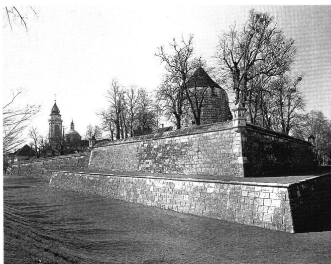
Fig. 10 Vue du Bastion de St-Ours prise du nord-est, avec la tour d'artillerie du Riedholz en arrière et la fausse-braie et le fossé au premier plan.
