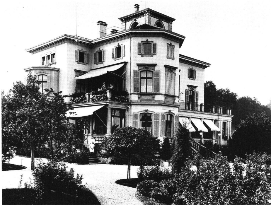
Abb. 4 Villa Bellaria, Zürich, von Leonhard Zeugheer, erbaut 1867–1870. Typisches Beispiel für Zeugheers spätere, in locker aneinandergefügte Baukörper aufgelöste Architektur der 1860er Jahre.
