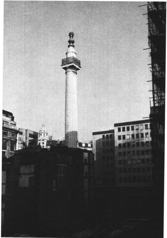
Abb. 6 Das «Monument» in London, von Christopher Wren, vollendet 1677. Zustand 1981, umgeben von Baulücken, Abriss- und Neubauten.
