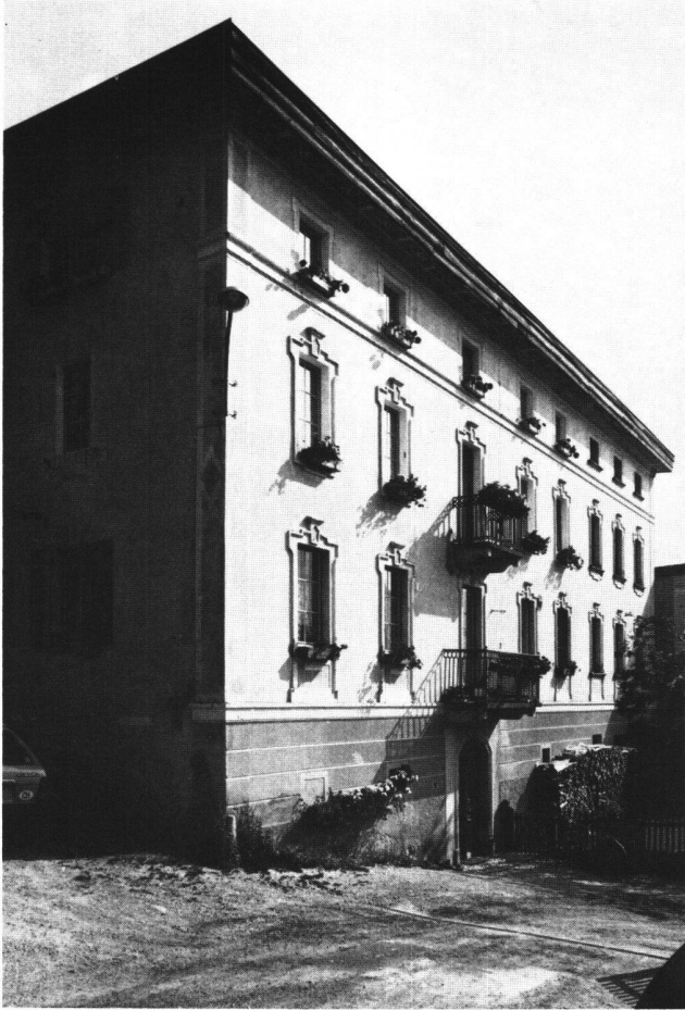
Abb. 4 Lavin. Das Bauernhaus Nr. 93 in Somchants besitzt eine prächtige neoklassizistische Palazzofassade. Hinter den letzten drei Fensterachsen rechts verbirgt sich die Scheune.
