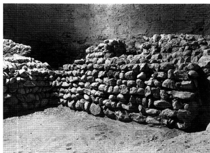
Abb. 8 Süd- und Ostmauer (2) des eingezogenen Rechteckchors (Phase 2), von Nordwesten.
