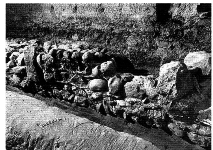
Abb. 9 Fundamentreste der Nordmauer (4) von Bau 3, Ansicht von Südosten.
