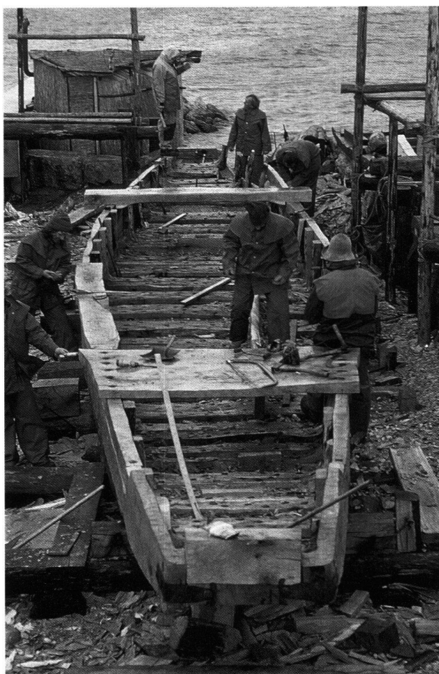
Fig. 1 Altaripa : réplique d'un chaland gallo-romain découvert à Bevaix pendant son assemblage.
