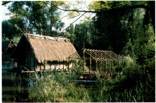
Abb. 3 Freilichtmuseum von Unteruhldingen (D) am Bodensee. Rechts das im Bau befindliche Arboner Haus, links das Hornstaader Haus.
