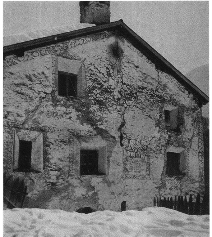
Abb. 6 Haus Stupaun (Haus Nr. 86) in Guarda vor der Renovation.
