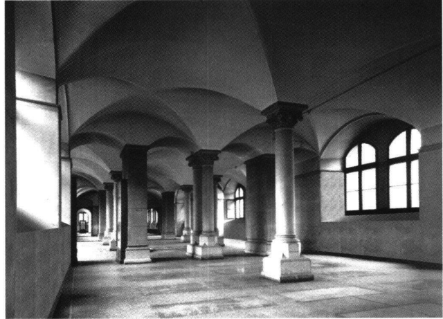
Abb. 7 Bahnhofflügel, Erdgeschoss. Pfeilerstellung noch nicht zugemauert, ein Raumeindruck, der rekonstruiert werden kann.
