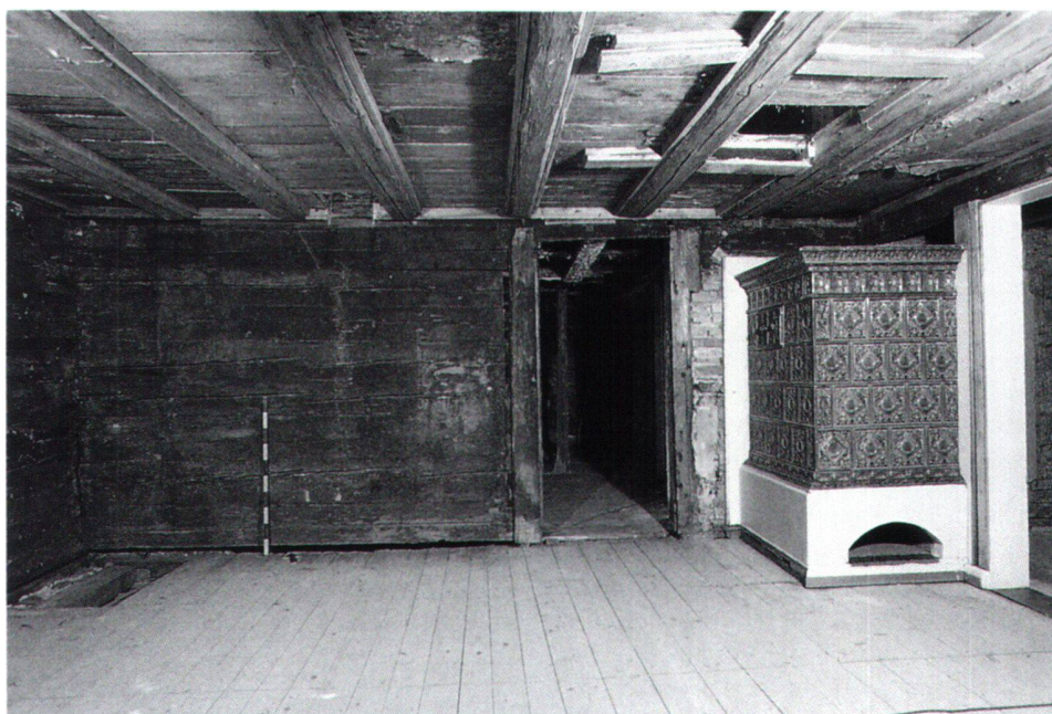
Abb. 11 Menzingen, Hauptstrasse 6: Nordwand der Stube im ersten Obergeschoss mit den beiden als «Mantelstüde» ausgebildeten Pfosten der Stubentür. Rechts der 2004 abgebrochene Kachelofen von 1904 am Standort des originalen Kachelofens. Blick nach Norden.
