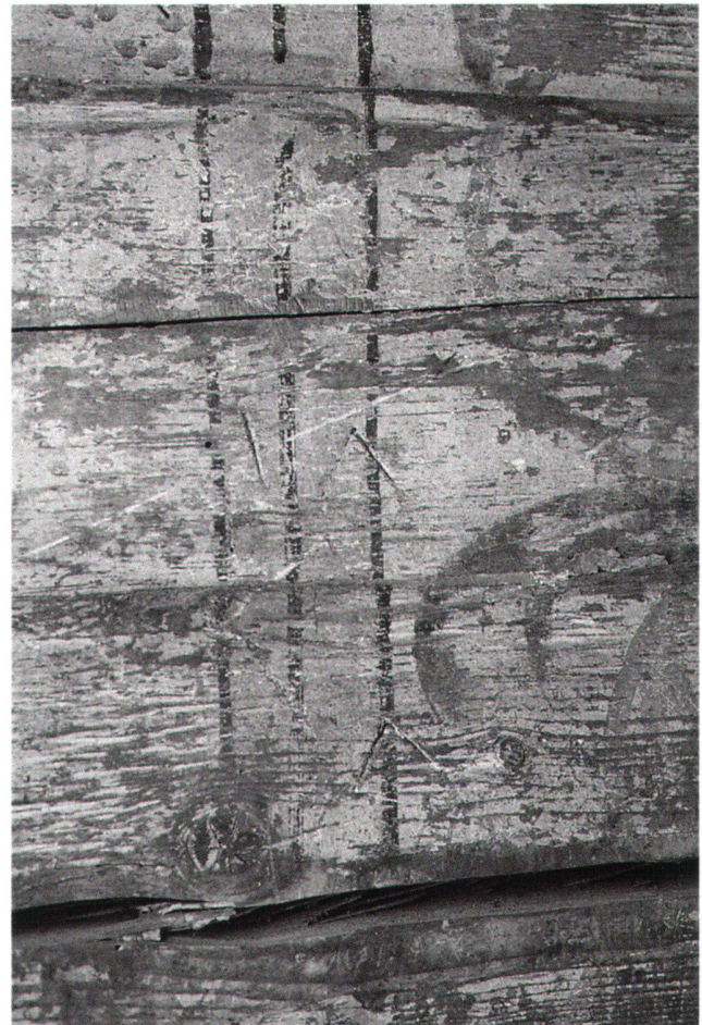
Abb. 22 Menzingen, Hauptstrasse 6: 1535 übermalte, eingekerbte Zahlzeichen («Abundzeichen») an der Westwand der Kammer im ersten Obergeschoss, Blick nach Westen.
