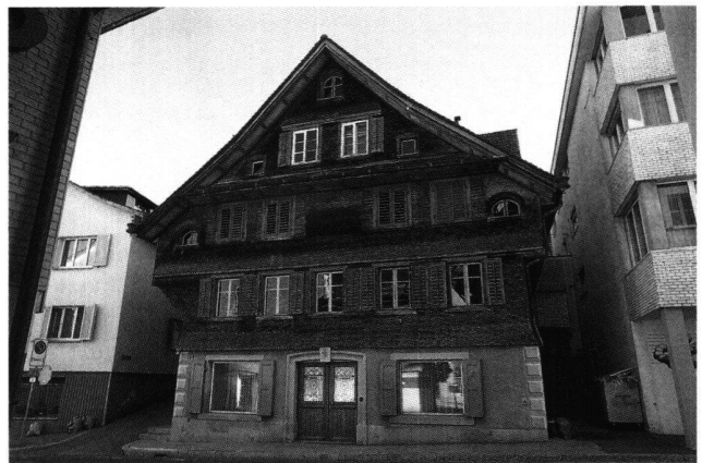
Abb. 1 Die Südfassade (Gassenseite) des Hauses Hauptstrasse 6 in Menzingen vor dem Umbau 2004. Blick nach Norden.
