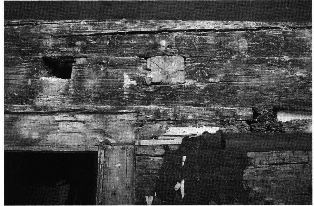
Abb.10 Menzingen, Hauptstrasse 6: Südfassade mit den «fassadensichtigen» Deckenbrettern des ersten Obergeschosses und dem abgesägten Vorstoss des obersten Balkens der Trennwand zwischen den beiden Kammern des ersten Obergeschosses. Darüber links der ebenfalls abgesägte unterste Vorstoss der Trennwand der Kammern des zweiten Obergeschosses. Blick nach Norden.
