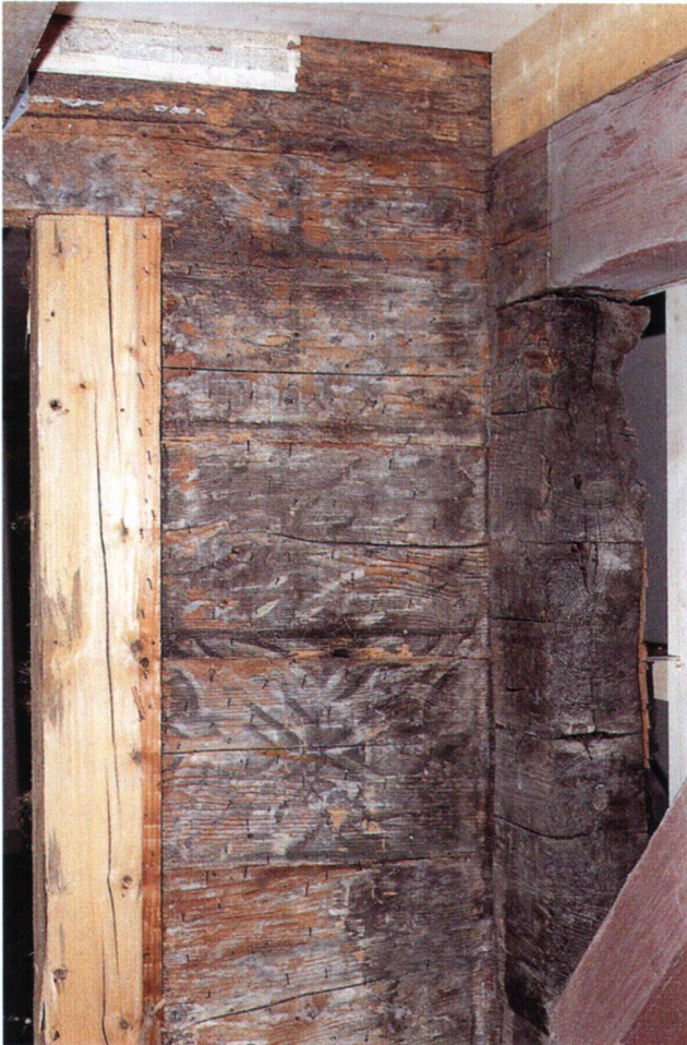
Abb. 19 Menzingen, Hauptstrasse 6: Südwestecke des Hauses, Blick nach Osten. Imitation verzierter Eckquader. Oben rechts ein Tragbalken der westlichen Laube.
