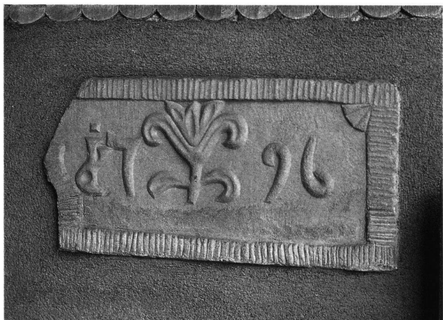
Abb. 23 Menzingen, Hauptstrasse 6: In der Westfassade des Kellersockels eingemauerter Stein mit der Jahreszahl 1796. Blick nach Osten.
