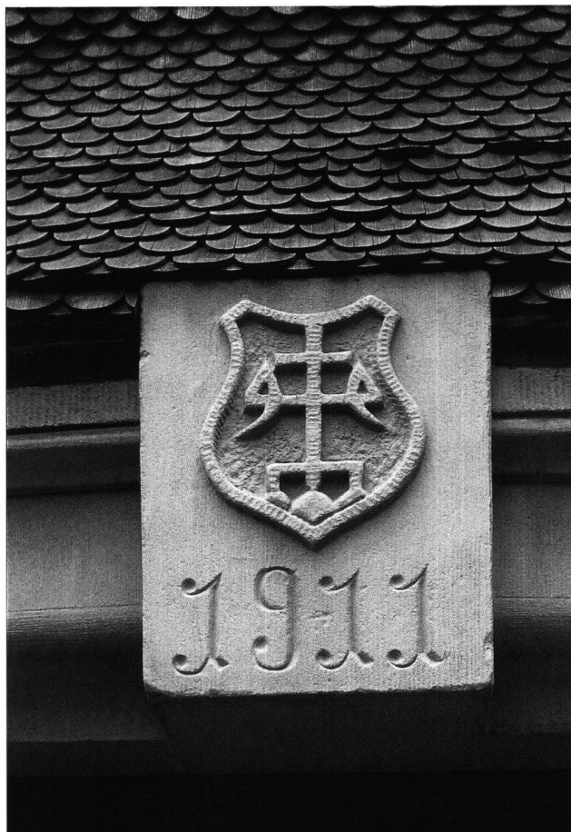
Abb. 24 Menzingen, Hauptstrasse 6: Portal des Kellers in der Südfassade mit Wappen Weber und Jahreszahl 1911. Blick nach Norden.
