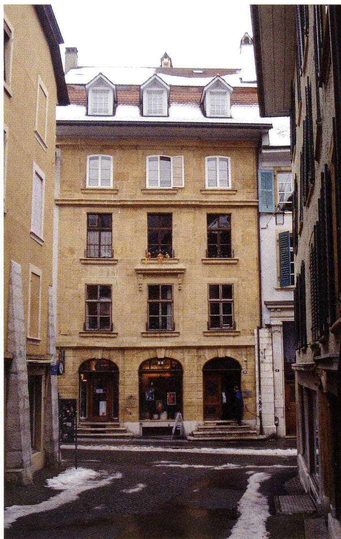
Abb. 1 Biel, Schmiedengasse 10. Gassenseitige Fassade, vermutlich 1760er Jahre.
