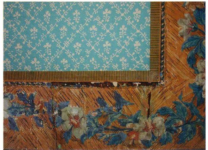
Abb. 18 Der 1967 angebrachte Ersatz für die grüne Unitapete sowie Originalbordüre mit abblättrender Malschicht, Situation 2006, Neue Burghalde Lenzburg.
