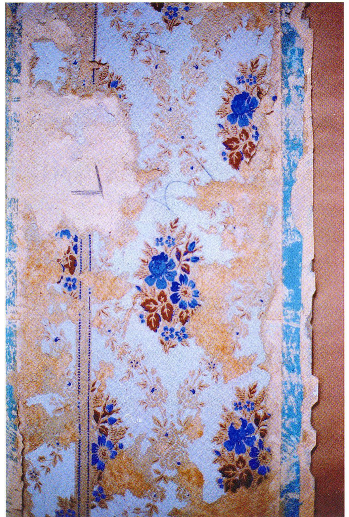
Abb. 9 Makulatursschicht auf der Rückseite einer der Tapetenbahnen. Die hier verwendete Ausspar-Technik deutet auf einen Frühdruck unbekannter Herkunft um 1760 hin (Zuschreibung von Ernst-Wolfgang Mick), Situation während Restaurierung 1986.
