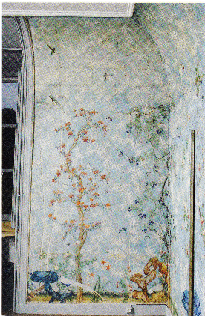
Fig. 3 Le mur avant dépose.
