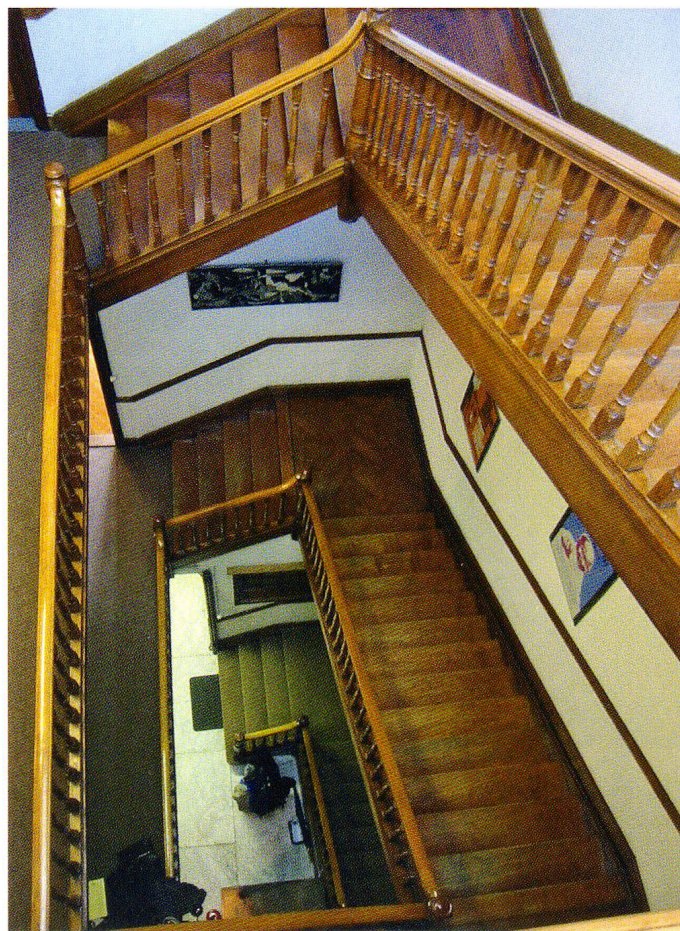
Fig. 5 Cage d'escalier avant restauration.
