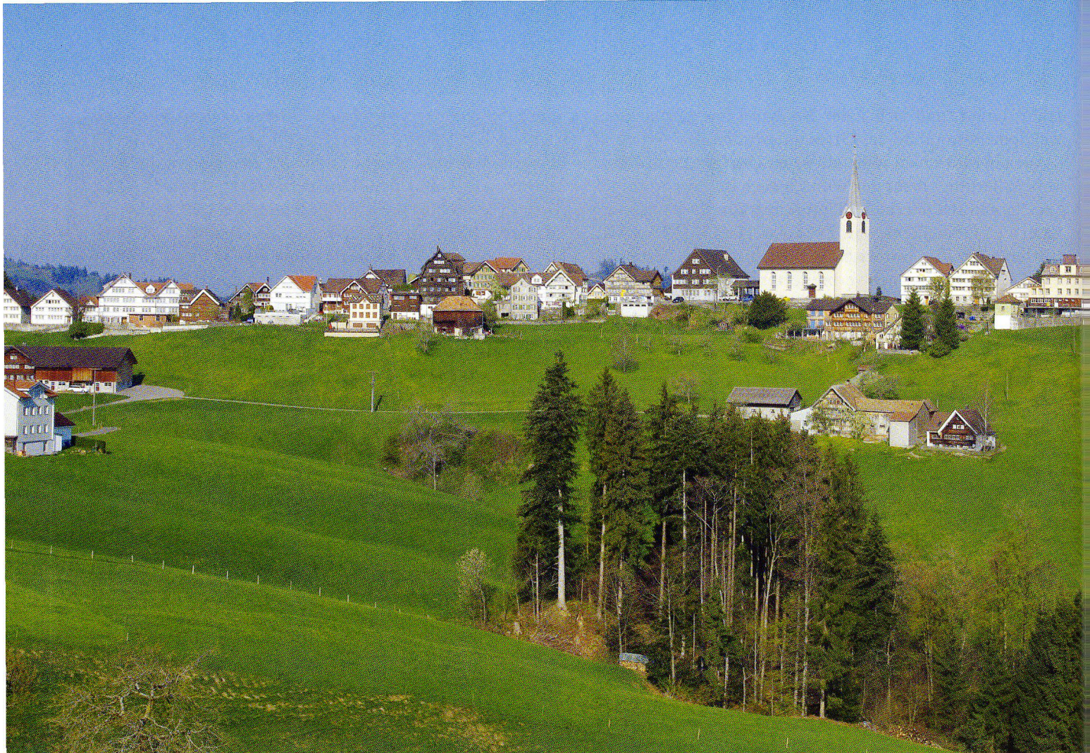
Abb. 20 Schwellbrunn in seiner charakteristischen Ansicht von Osten, Foto 2011.
