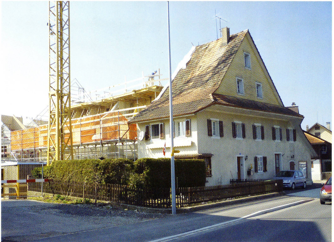
Abb. 24 Mettmenstetten, Rossau. Für das Ortsbild ist der Erhalt des an der Strasse liegenden Wohnteils eminent wichtig, der Ersatz der deutlich jüngeren Scheune ist verkraftbar, Foto 2010.
