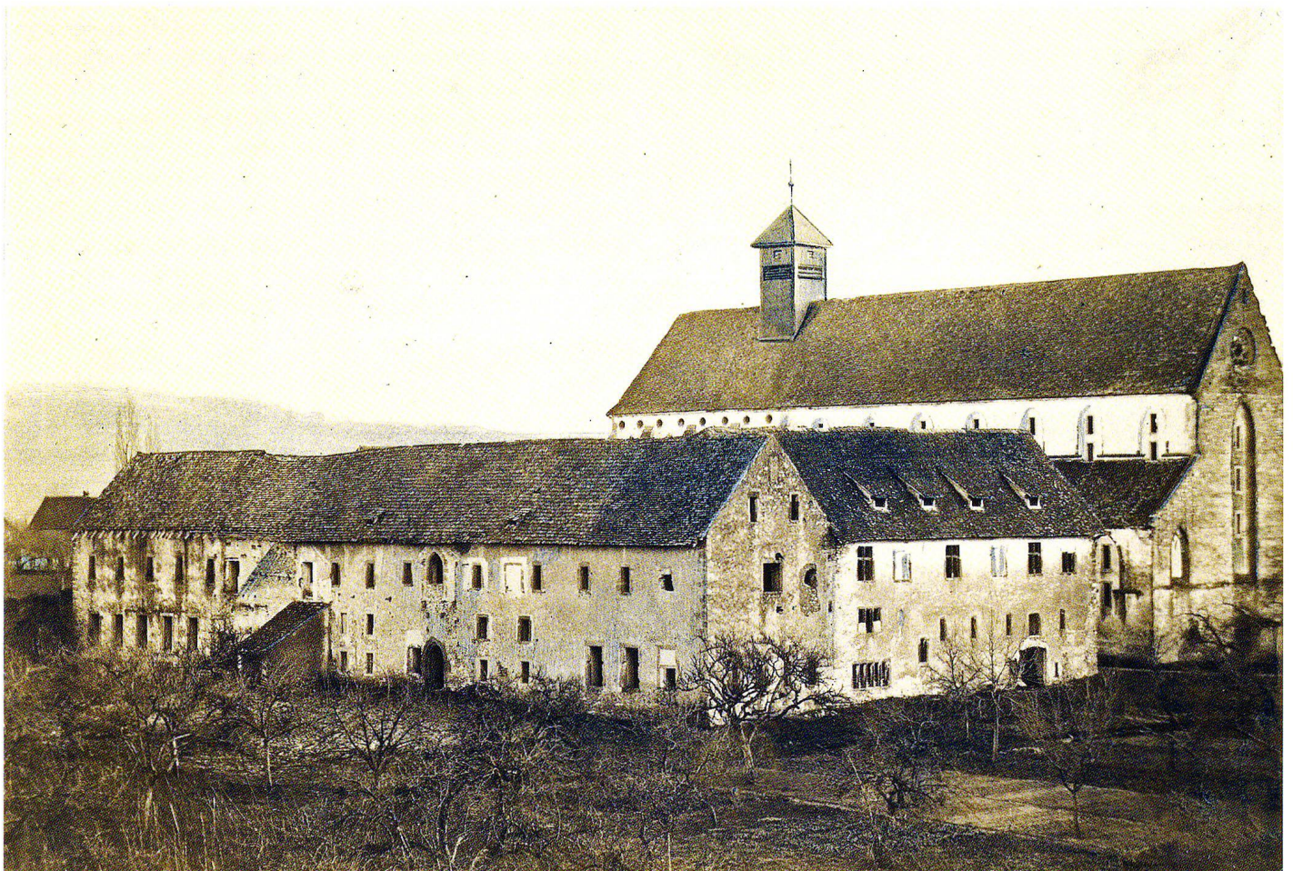
Abb. 1 Ehemaliges Kloster Königsfelden vor dem Abbruch um 1869. Fotografie, 13,2 × 18,7 cm. Kantonale Denkmalpflege Aargau.
