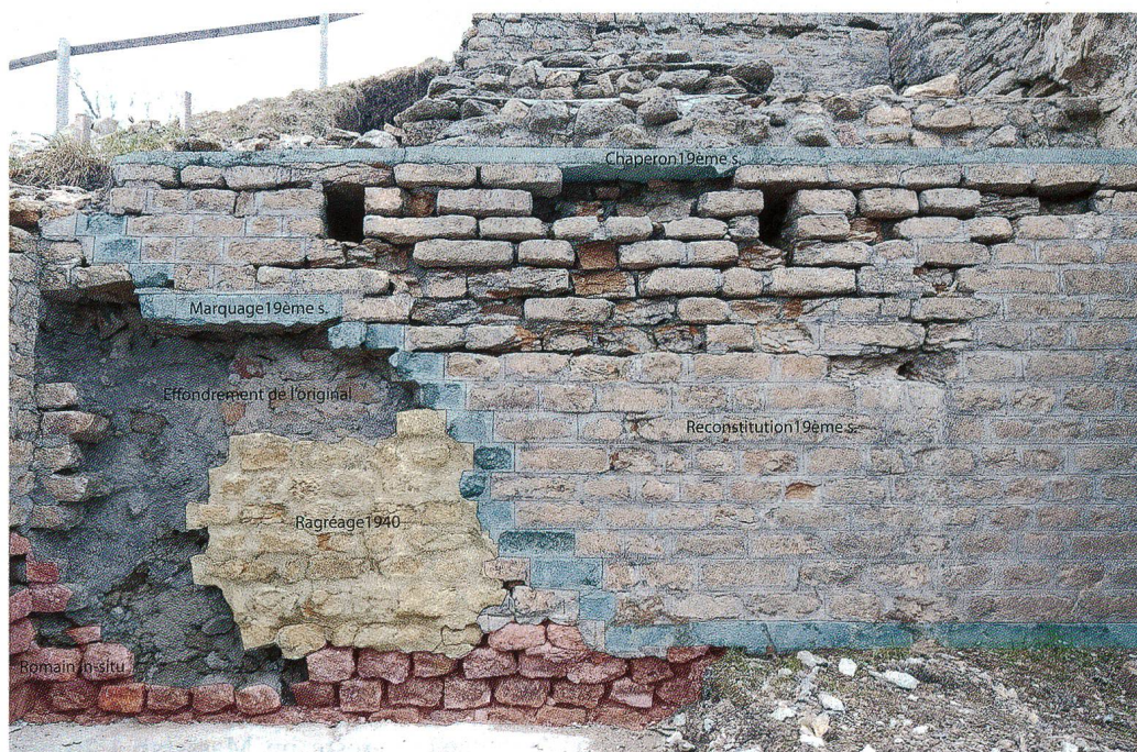
Abb. 9 Aventicum/Avenches (VD), théâtre romain. Aditus sud-ouest, mur M90.2. De haut en bas: chape en ciment (bleu), parement en moellons romains réutilisés au 19 ème siècle (neutre, joints en ciment tirés au fer), assise en briques de ciment marquant la limite de cette restauration (bleu), parement romain en place au 19 ème siècle (rouge, joints en ciment tirés au fer totalement érodés), ragréage en ciment, vers 1940, d'une partie originale effondrée (jaune, moellons romains réutilisés, joints en ciment brossés en léger retrait). La plus grande partie du parement d'origine s'est effondrée (gris), 2013.
