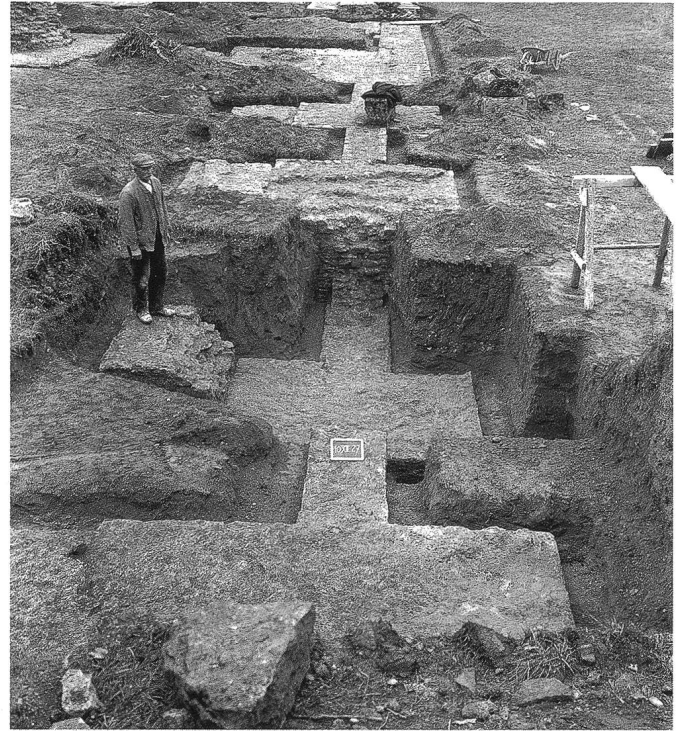
Abb.3 Aventicum/Avenches (VD), römisches Theater. Nordöstliche Eingangshalle nach der Freilegung im Jahre 1927. Die Fundamente der pfeilerartigen Verstärkungen in der Fassadenmauer sind stellenweise bis tief unter das Bodenniveau abgebrochen. Blick von Nordosten.
