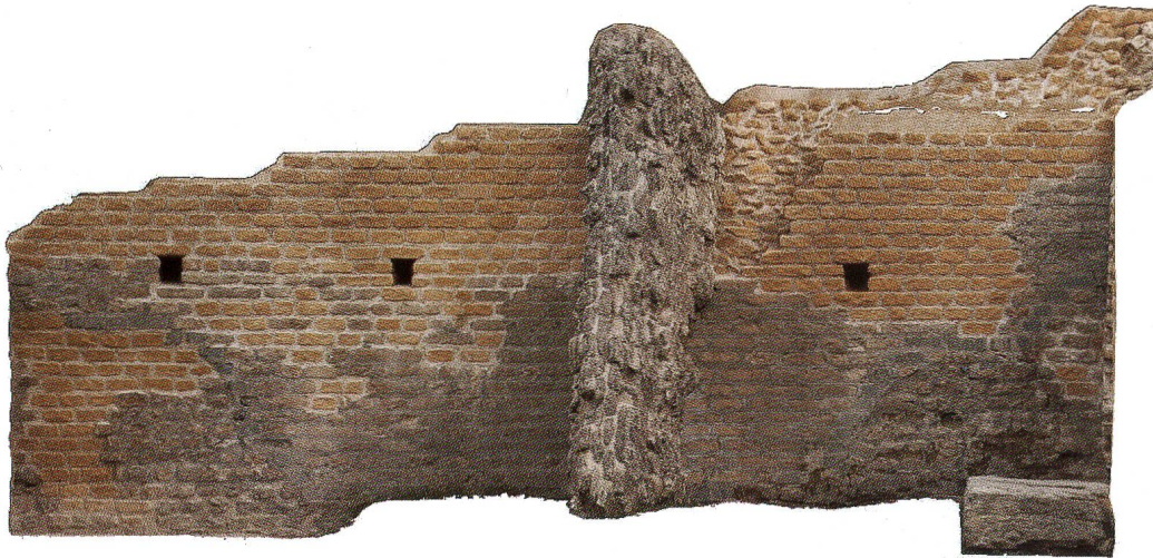
Abb.10 Aventicum/Avenches (VD), théâtre romain. Aditus sud-ouest, mur M90, état après restauration, lacunes comblées avec des moellons en pierre de Metz et rehaussement de la maçonnerie de deux à quatre assises dans le but de protéger le noyau romain et de permettre une bonne évacuation des eaux météoriques, 2013.
