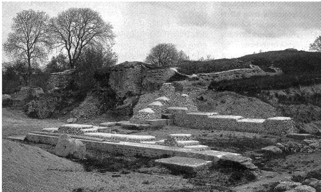
Abb. 4 Aventicum/Avenches (VD), Ost-Aditus und östliche Eingangshalle des Theaters um 1904. Während im Bereich des aditus (rechte Bildhälfte) bereits Restaurierungsarbeiten erfolgt sind, präsentiert sich die Zone der östlichen Eingangshalle (linke Bildhälfte) noch weitgehend im Grabungszustand. Blick von Westen.
