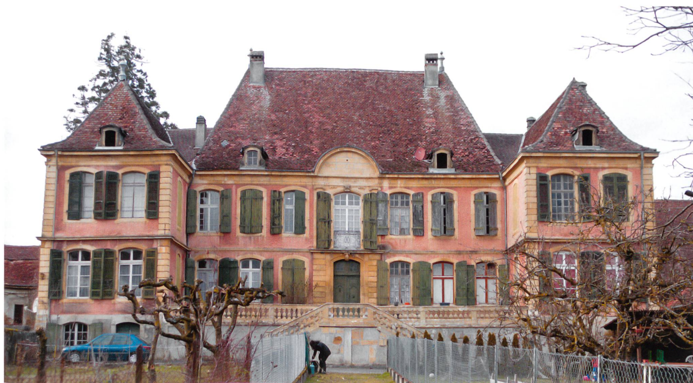
Abb. 10 Château Grandcour, erbaut 1738 durch Abraham Sinner.
