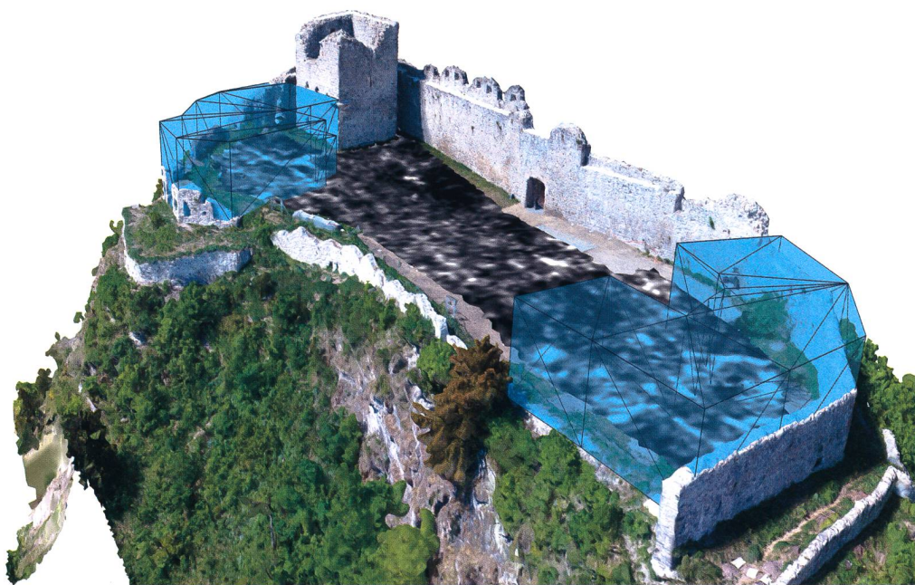
Abb. 13 Abbildung auf der Informationstafel zur Burg Castels bei Luzein GR mit der auf Basis eines 3D-Modells und geophysikalischer Prospektion rekonstruierten Anlage.
