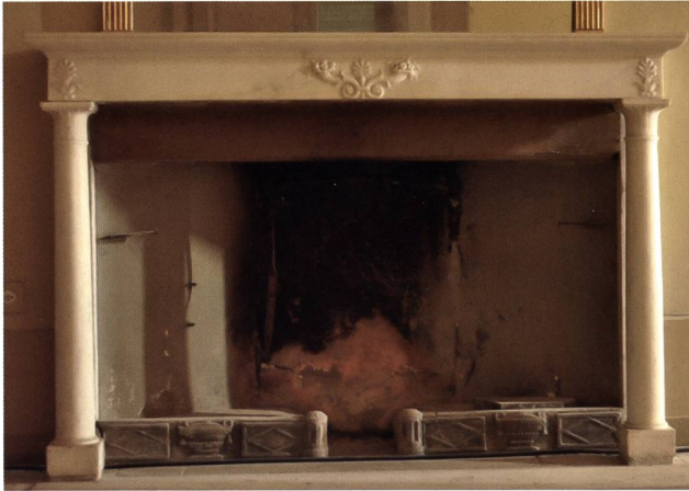
Fig. 27 Cheminée, Lorenzo Bartolini (atelier). Gilly, villa de Beaulieu, salon du rez-de-chaussée.
