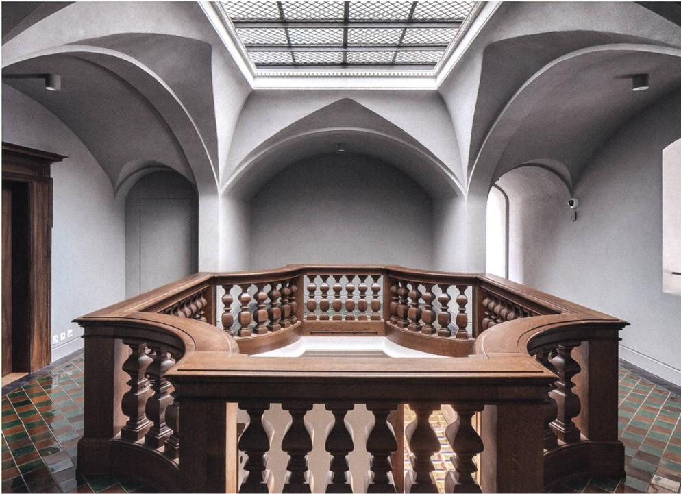
Abb. 5+6 Der wiederhergestellte Deckendurchbruch im Vorraum Obere Kapelle,
