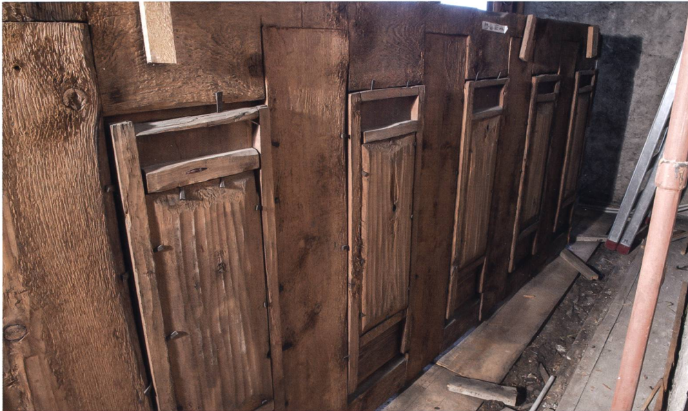
Abb. 3 Rückseite einer Wandverkleidung, welche die Konstruktion und Holzverbindungen offenbart. Seidenhof-Stube, Landesmuseum Zürich.
