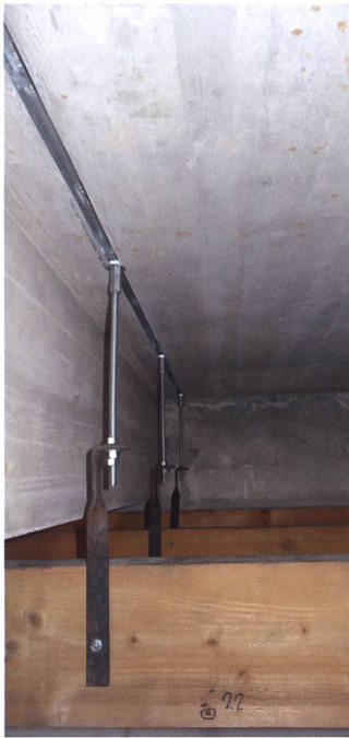
Abb. 31 Deckenaufhängung der Unterkonstruktion mithilfe einer Kombination aus neuen Halfenschienen und alten Stahlankern. Wasser-Stube aus der Rosenberg, Stans, Landesmuseum Zürich.
