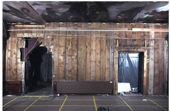
Abb. 13 Komplette Blindtäfelung aus sägerohen Brettern als Unterkonstruktion. Lochmannsaal, Landesmuseum Zürich.
