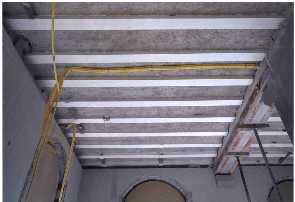
Abb. 29 Neu betonierte Decke und mit Spritzputz als Brandschutz ummantelte Stahlträger nach der Sanierung. Raum Korridor 00.102.H, Landesmuseum Zürich.
