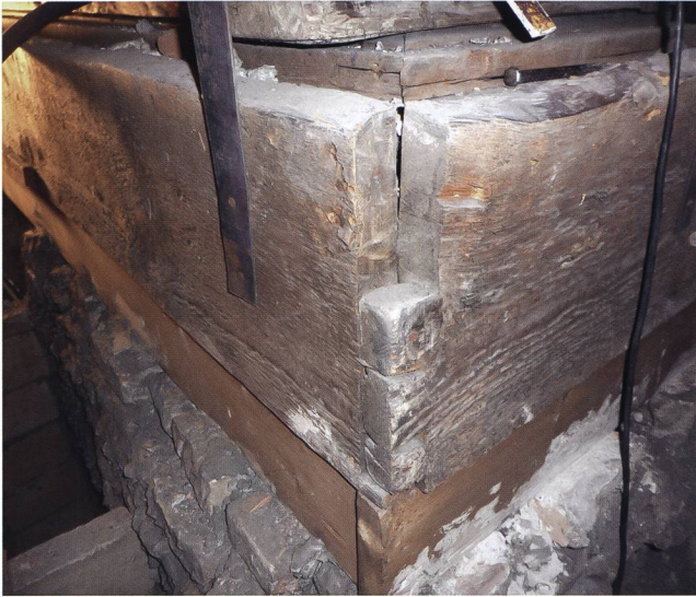
Abb. 6 Halb abgesägte und gezinkte Eckverbindung eines Deckenrahmens. Seidenhof-Stube, Landesmuseum Zürich.
