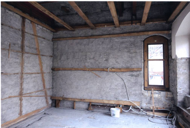
Abb. 11 Unterkonstruktion aus angeschraubten Latten. Die Riegelwand links im Bild wurde als Bestandteil des Museumsgebäudes ebenfalls als Unterkonstruktion genutzt. Wiggen-Stube, Landesmuseum Zürich
