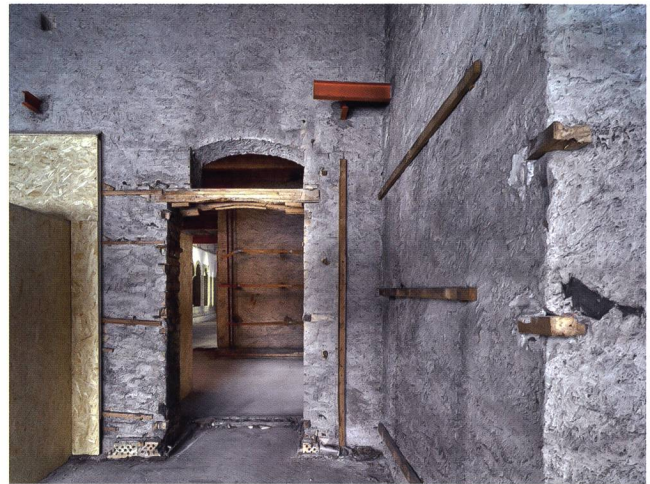
Abb. 10 Unterkonstruktion aus angeschraubten und eingeputzten Dachlatten. Privatstube aus der Fraumünsterabtei Zürich, Landesmuseum Zürich.
