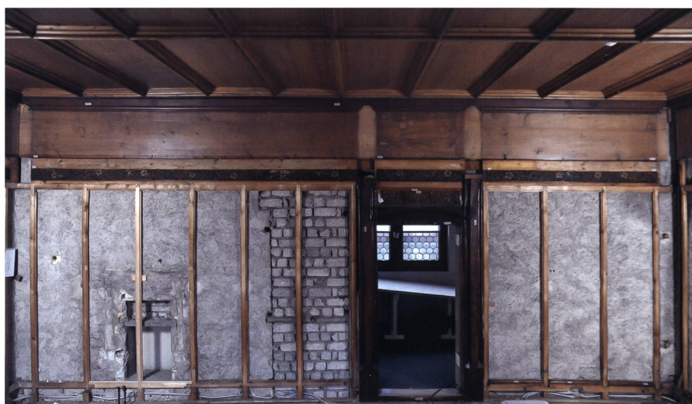
Abb. 2 Teilweise ausgebaute Täfer mit freigelegter Unterkonstruktion, 2016. Oetenbach-Stube, Landesmuseum Zürich.
