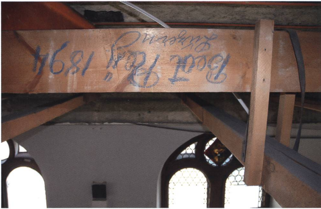
Abb. 23 Signatur des Schreiners Beat Rey von 1894 auf einer Deckenunterkonstruktion, der am Einbau der Decke beteiligt war. Decke aus dem Schloss Arbon, Landesmuseum Zürich.
