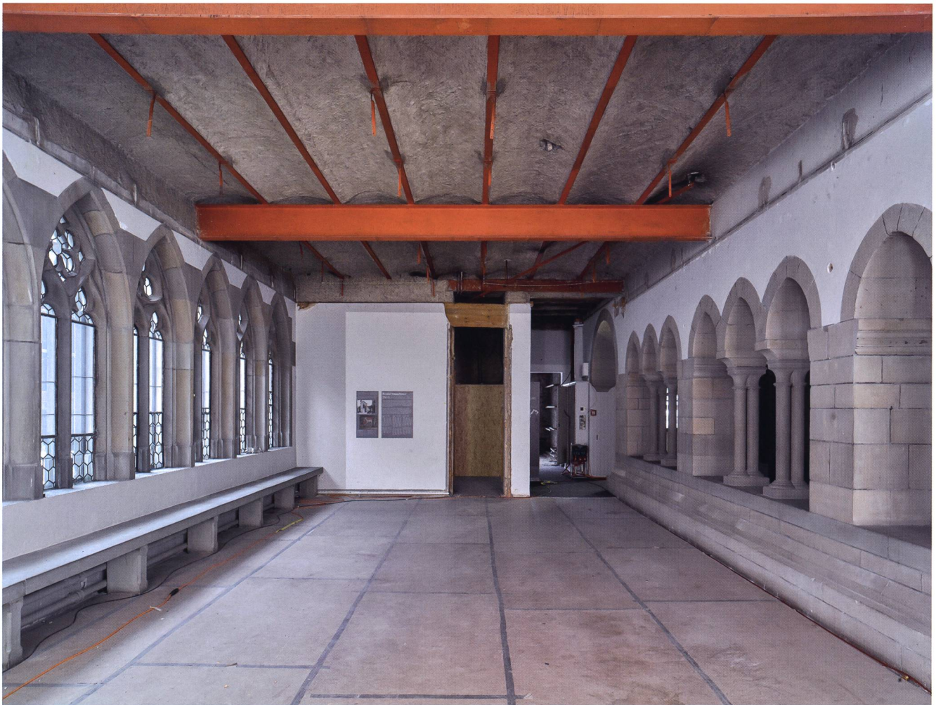
Abb. 26 Originale Betondecke mit Stahlträgern von 1898 nach dem Ausbau der Holzdecke aus der St. Sebastianskapelle, Igels. Oberer Kreuzgang, Landesmuseum Zürich.
