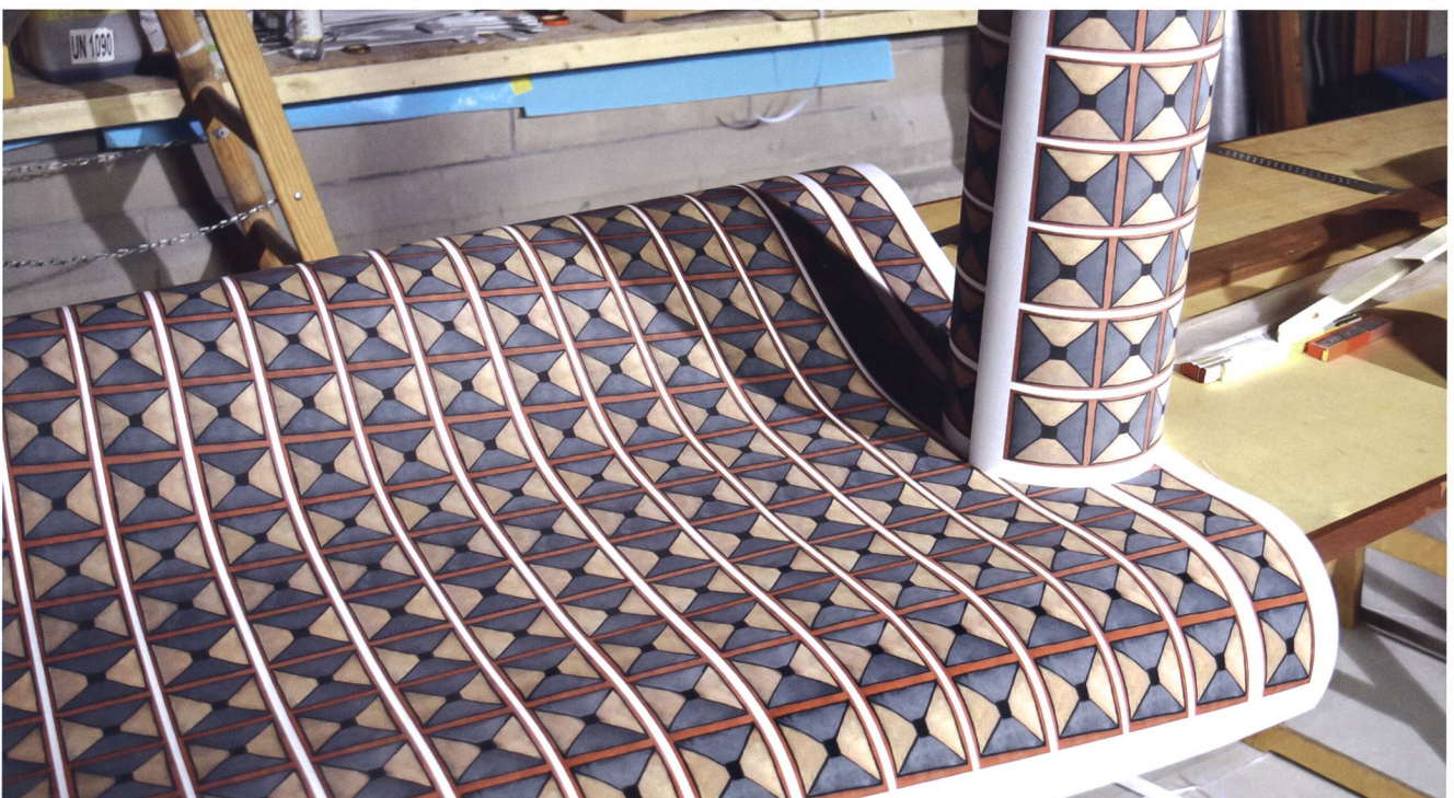
Abb. 36 Gedruckte Papierstreifen für die Rekonstruktion der Abdeckleisten an der Decke aus dem Schloss Neunkirch. Die einzelnen Streifen wurden passend ausgeschnitten und auf die Holzleisten aufgeklebt.
