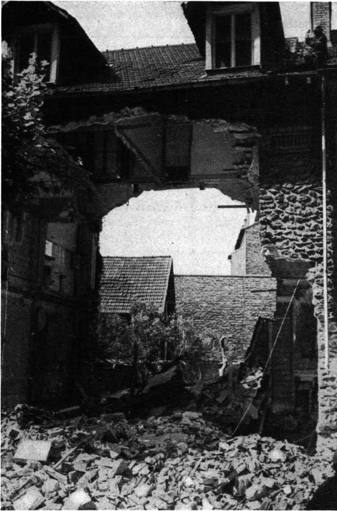
Abb. 18. Sekundäre Trümmerwirkung: Das Bruchsteinmauerwerk mit schlechtem Mörtel hat keine grosse Festigkeit. Durch die Bombenexplosion hinter dem Haus wurde ursprünglich nur etwa der zehnte Teil der auf dem Bild erkennbaren Zerstörung verursacht. Die grosse Zerstörung ist durch das «Umhebeln» der Mittelwand durch die Gebälke und das Nachrutschen des Mauerwerkes entstanden. Die Bombe war klein, denn die Ziegel auf der Scheune hinten sind nur wenig verschoben. Die noch erhaltenen Wände zeigen keine Zerstörung durch Splitter. Der Spiegel im 1. Stock und die Verglasung der Dachfenster sind noch intakt. Das Dach wurde nicht zerstört. Die Trümmer bilden kleine Klumpen; sie liegen senkrecht unter ihrem früheren Standort. Es sind deutlich zwei Haufen, für die Fassade und für die Mittelwand, zu unterscheiden. Eine kleine Zerstörung brachte das ganze Haus zum Einsturz.
