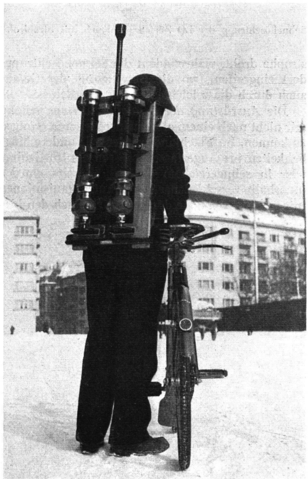
Schnelllöschtrupp der LO Zürich (Hydrantengarnitur)
