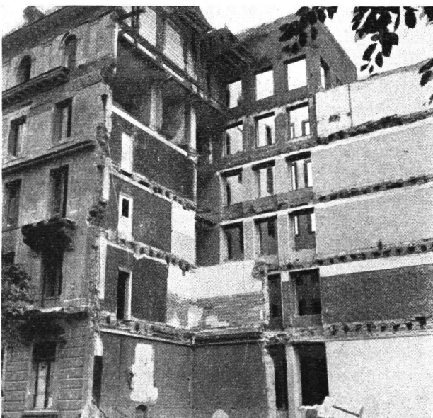
Nach einer Teilsprengung (Baden)
