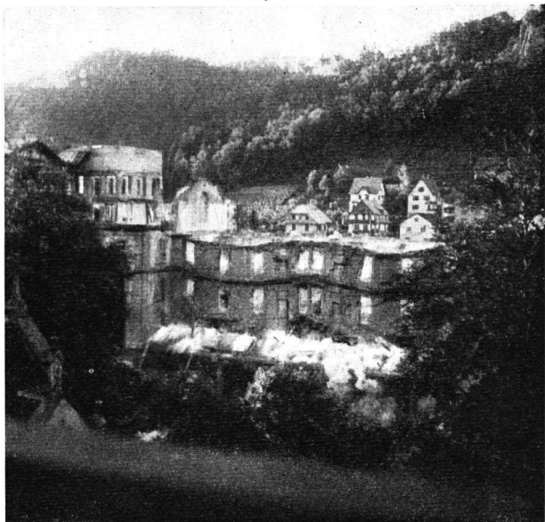
Sprengung eines Gebäudeteiles (Baden)
